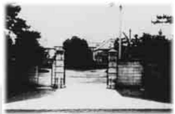
時計台着工前の正門風景。すでにクスノキが植わっている。
