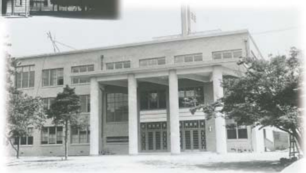
竣工したばかりの第三高等学校本館(1936年6月)
