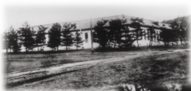
理工科大学純正化学教室本館
